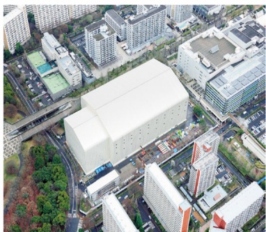
清掃工事建替工事の工事棟および煙突部テント全景
