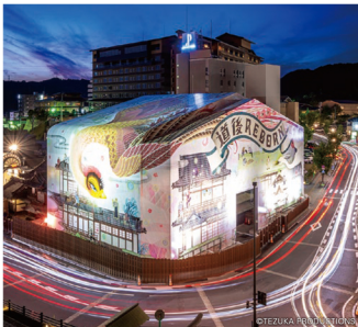
道後温泉本館保存修理工事 松山市様はテント自体にラッピングアートを展開。修繕中も周囲に魅力をアピール
